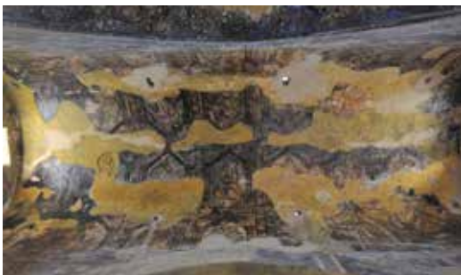
2.8. Aisle IB (central)
